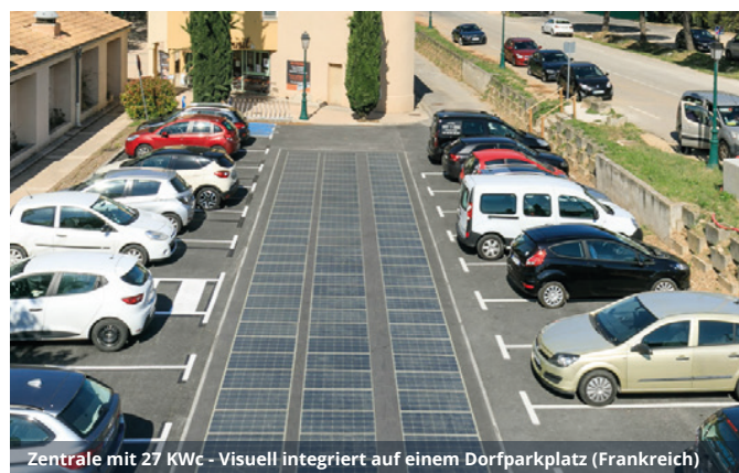
Zentrale mit 27 KWc - Visuell integriert auf einem Dorfparkplatz (Frankreich)
