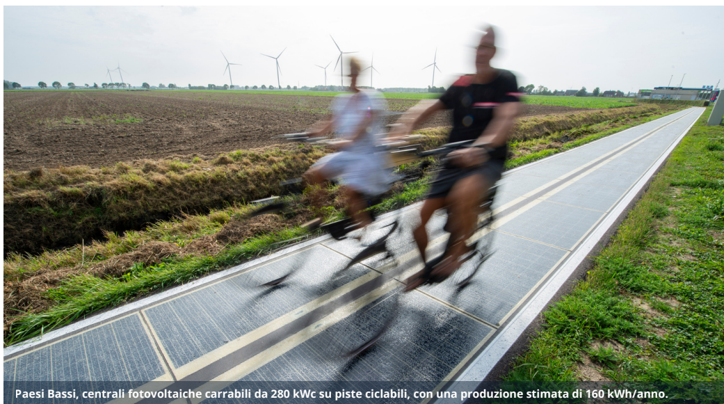
Paesi Bassi, centrali fotovoltaiche carrabili da 280 kWc su piste ciclabili, con una produzione stimata di 160 kWh/anno.
